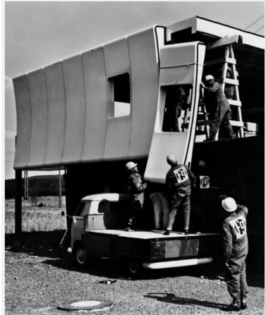
Aufbau des Prototypen im Mai 1968 zwischen 7 und 17 Uhr aus 13 Dach- und 26 Wandelementen aus GFK. Bild: Wolfgang Feierbach.
